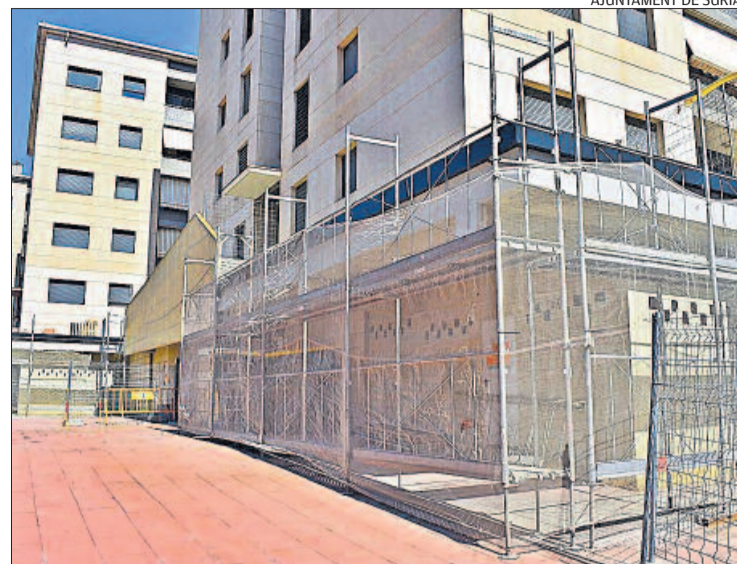
Renovació de baranes al Grup Sant Sebastià del barri de Salipota
