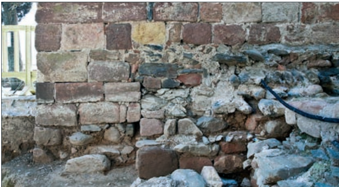
Les excavacions a la Torre Roja formen part del patrimoni del municipi
