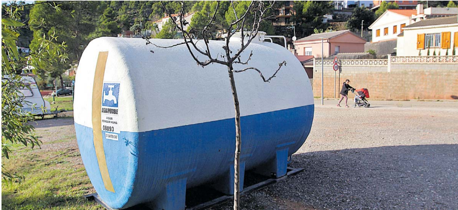
Un dels dos dipòsits provisionals d'aigua potable que Mina Pública d'Aigües de Terrassa va instal·lar al municipi.
